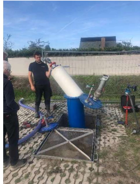
Figuur 14 Inspectie koppelleiding op Urk
