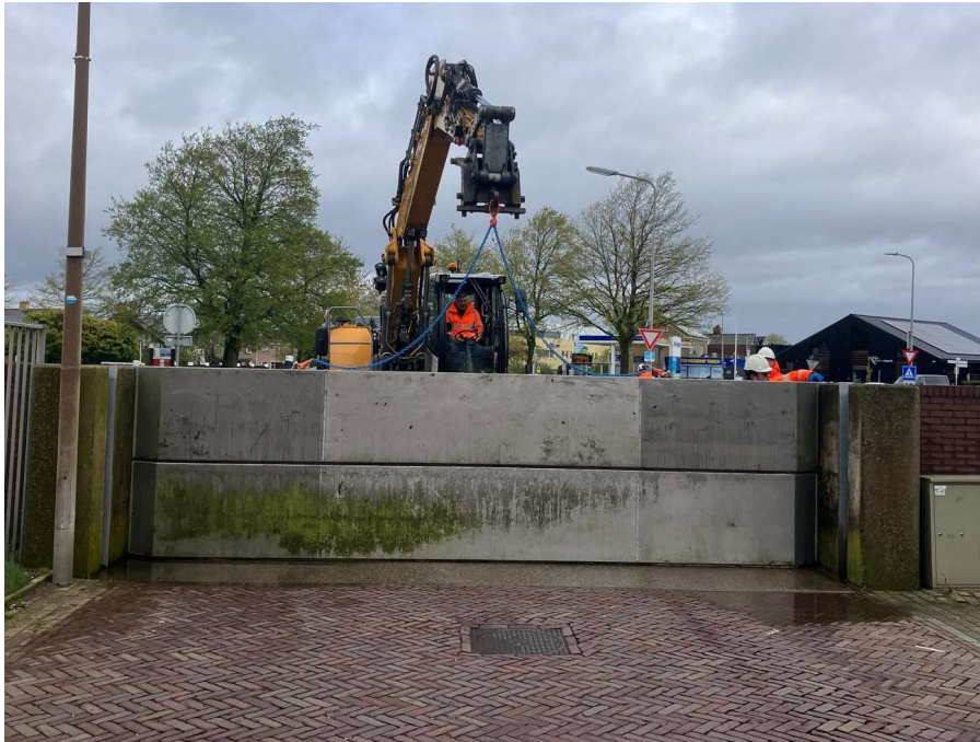
Figuur 7 De coupures op Urk worden gesloten als onderdeel van de jaarlijkse proefsluiting
