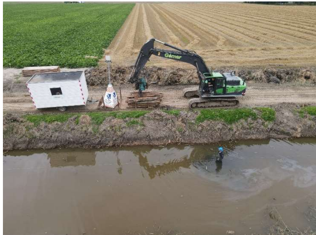
Figuur 8 Vervangingsonderhoud van een oeverbeschoeiing
