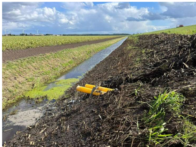
Figuur 4 Herprofilering van de kwelsloot, na vervanging van de dijkdrainage aan de Eemmeerdijk
